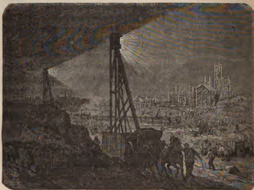
FIG. 2. Éclairage à l'électricité d'un chantier de construction.
